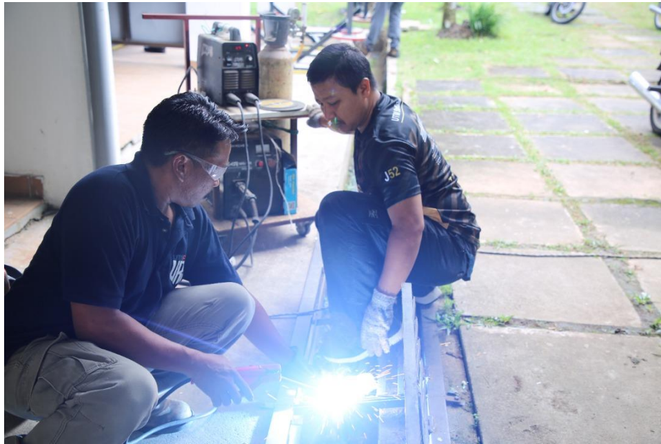
Kerja memperbaiki penutup longkang yang sudah berkarat
