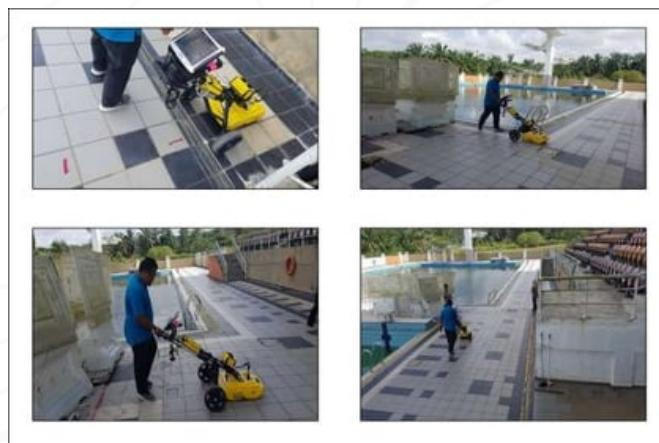
Rajah 2 : Proses Imbasan Bawah Tanah Menggunakan GPR
